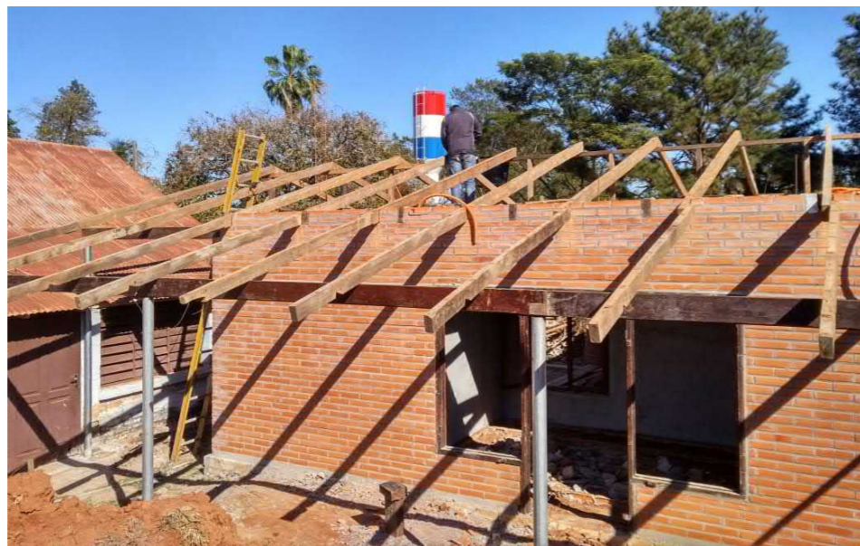
Bau der Comisaría Friesland
