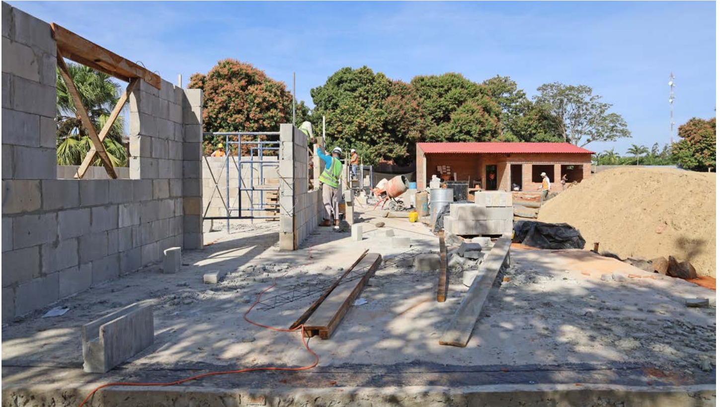
Die Bauarbeiten der Seniorenresidenz schreiten voran. Foto: Die Redaktion
