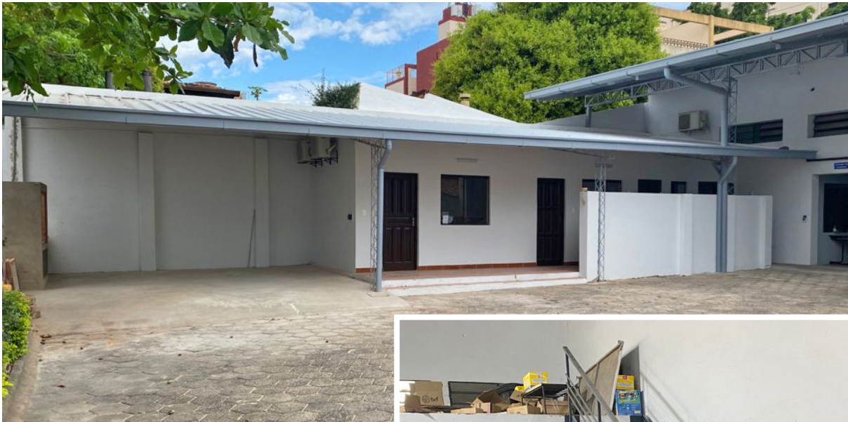
Renovierte Zimmer und Toiletten.
