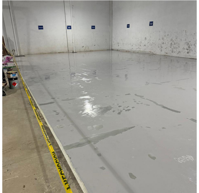
Reparatur des Lagerbodens
